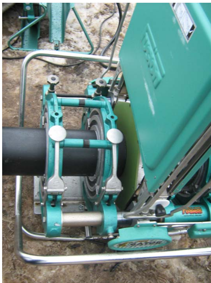
Нагрев и оплавление свариваемых поверхностей нагревательным элементом
