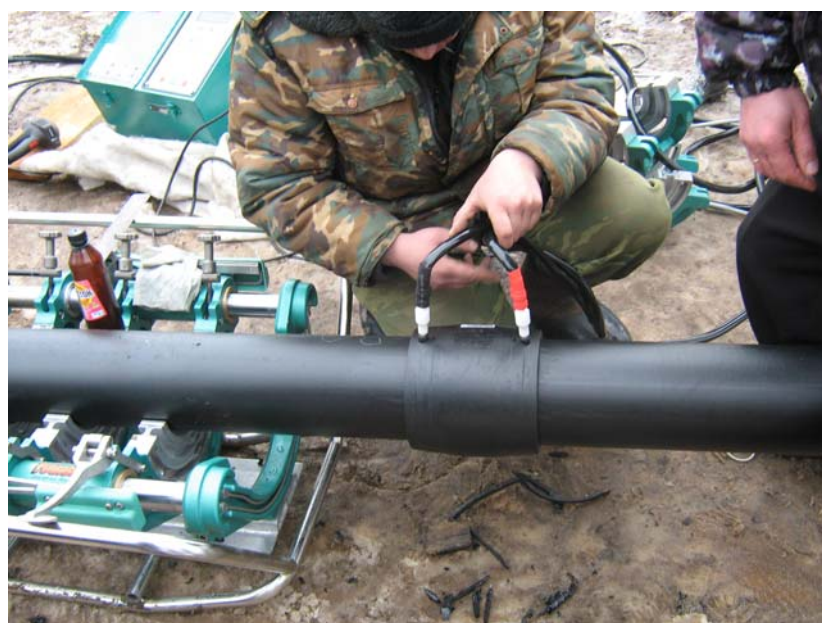
Приварка муфты с закладным нагревателем
