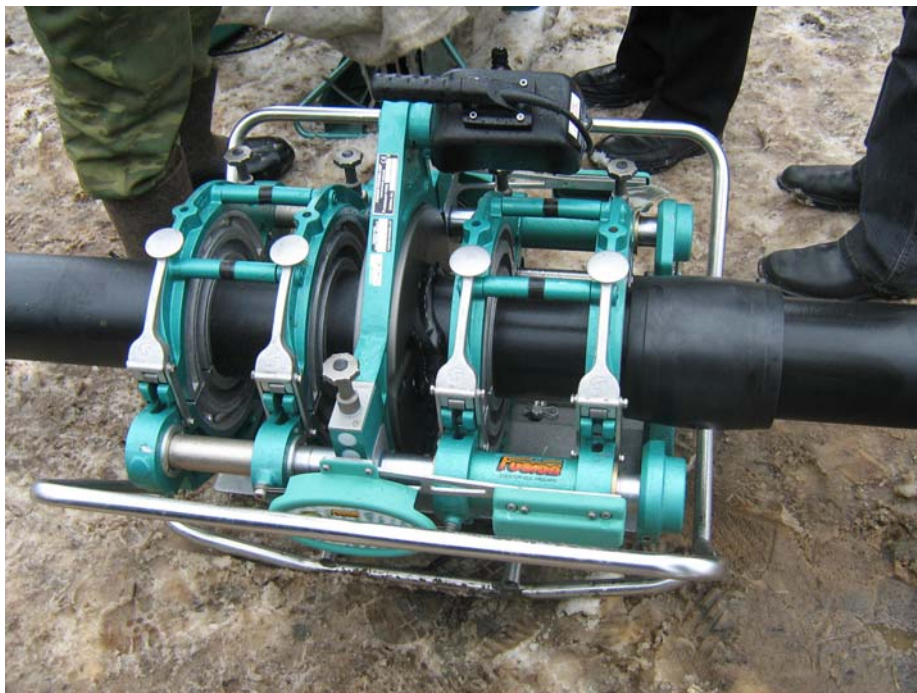
Механическая обработка торцов труб с помощью торцевателя
