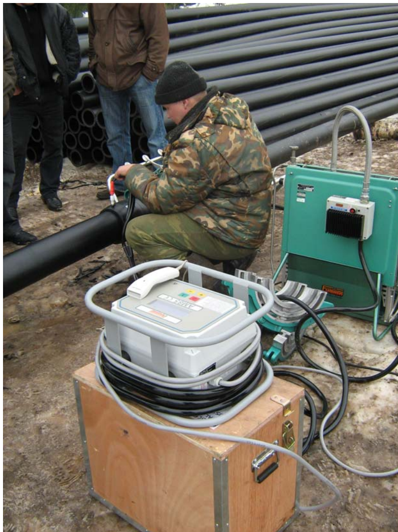
Усиление сварного шва муфтой с закладным нагревателем
