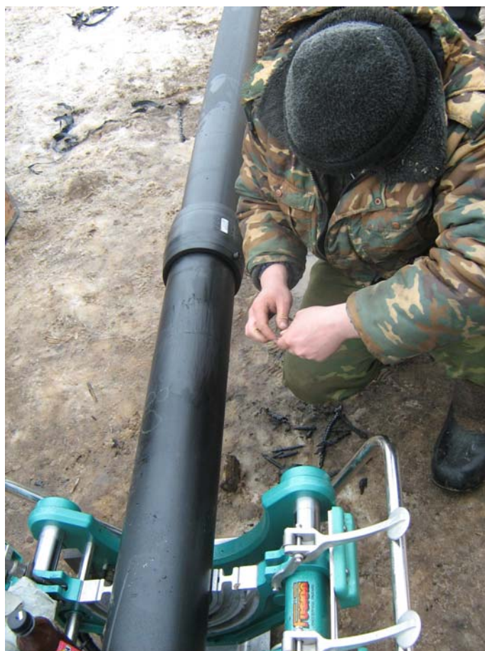
Удаление сварного грата и подготовка поверхности трубы под сварку муфтой с закладным нагревателем
